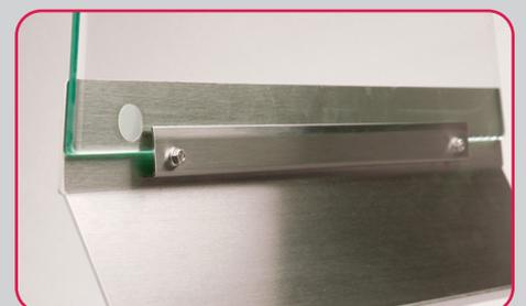
El cristal tiene un recubrimiento especial que actúa de protección superficial. Este recubrimiento reduce el efecto abrasivo de la arena y evita accidentes en caso de rotura. La sustitución de cristal es muy sencilla.
